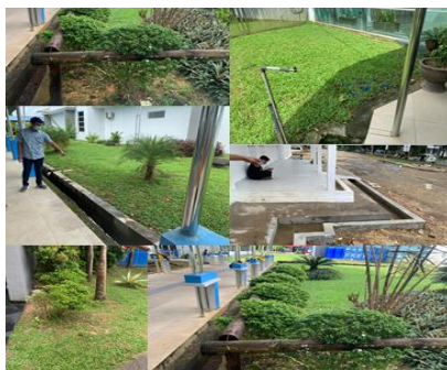
Gambar 4. Peninjauan lokasi pemasangan TCT
